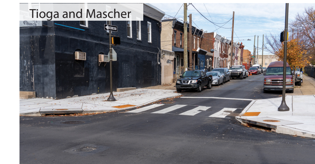
Concrete curb extension Extensión de banqueta de concreto
