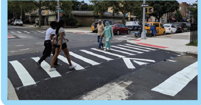
Raised crosswalk Cruces de peatonales elevados
