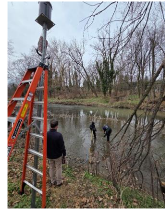
S. 65 th St. Bridge
