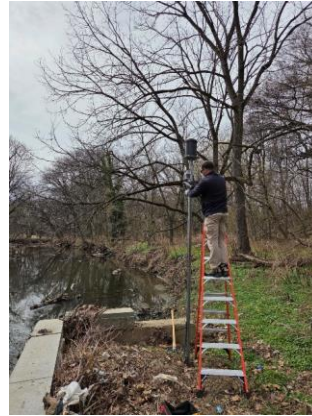
S. 70 th St. Bridge
