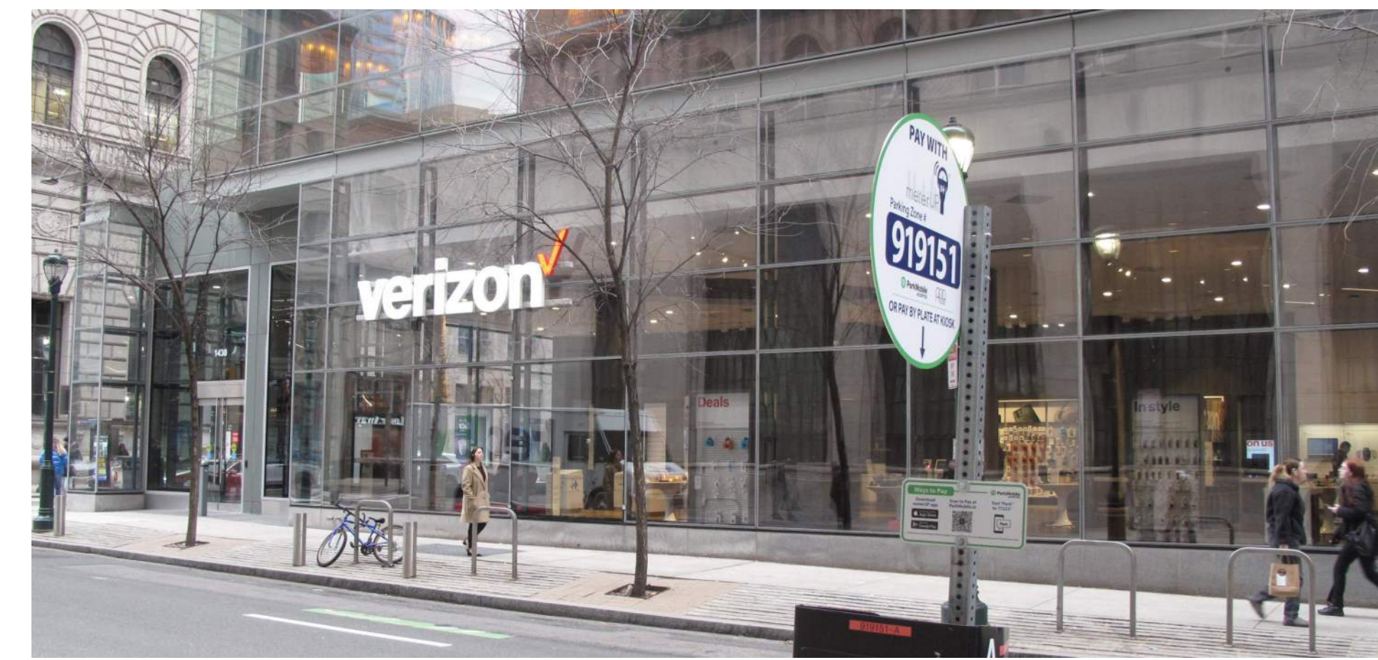
1 EXISTING FACADE VIEW 1 SCALE: N.T.S.
