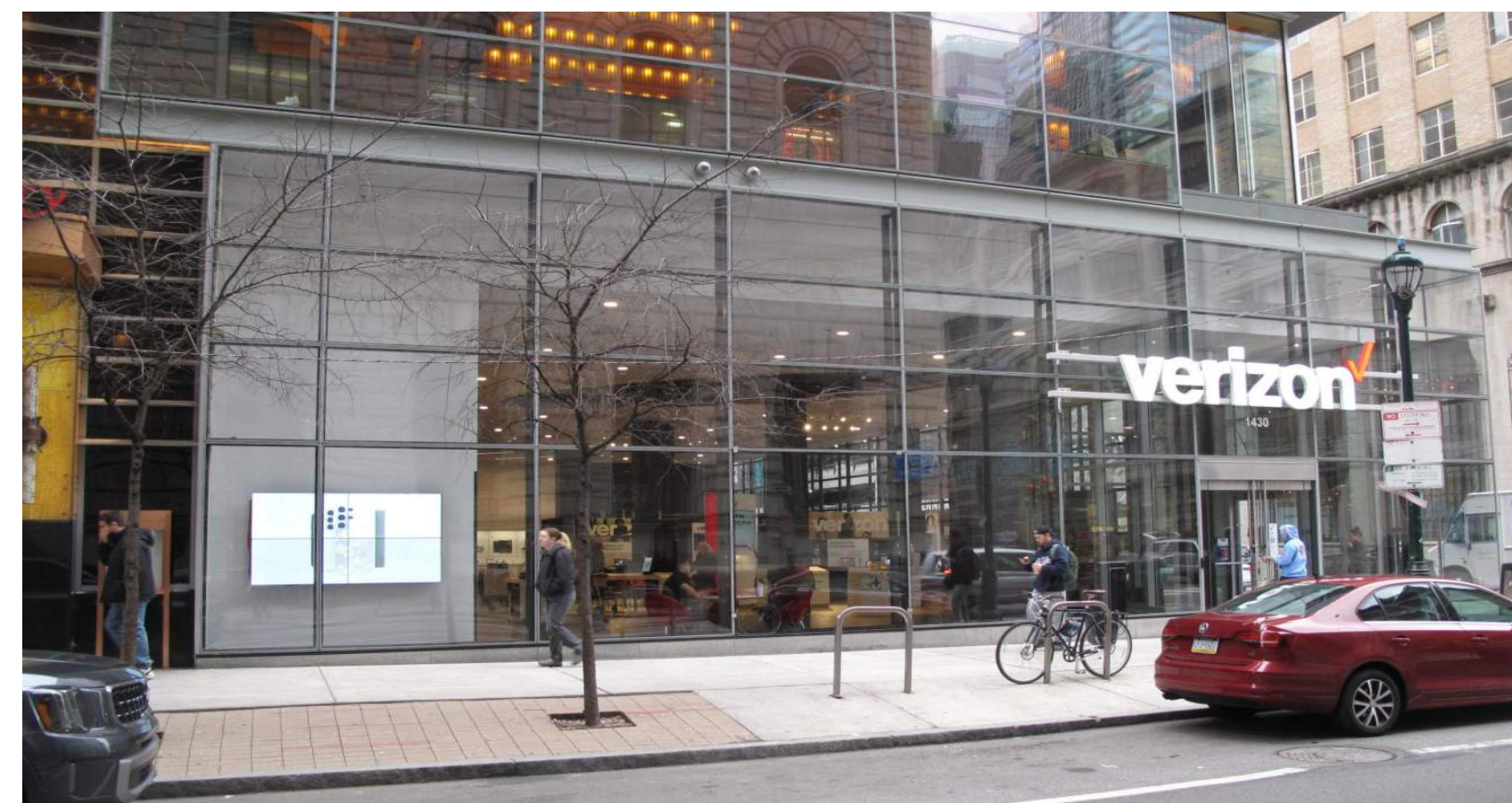
2 EXISTING FACADE VIEW 2 SCALE: N.T.S.
