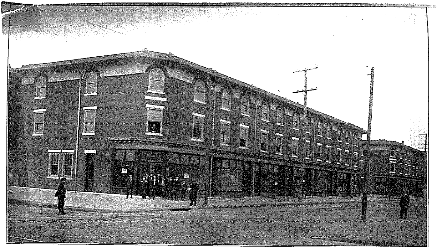
Veduta di una piccola sezione di case di proprietà del signor G. Tumolillo nella 8.a strada e Washington Ave. Il Tumolillo è proprietario di 45 case, costruite con criteri moderni, che costituiscono una sezione del quartiere italiano di Philadelphia. E' uno dei principali business men di Philadelphia, e dirige un ben avviato Ufficio Bancario, con una Succursale a Napoli. E' Presidente della Lega dei Banchieri e Agente Generale della "Veloce" e uno degli Agenti Generali dei...
